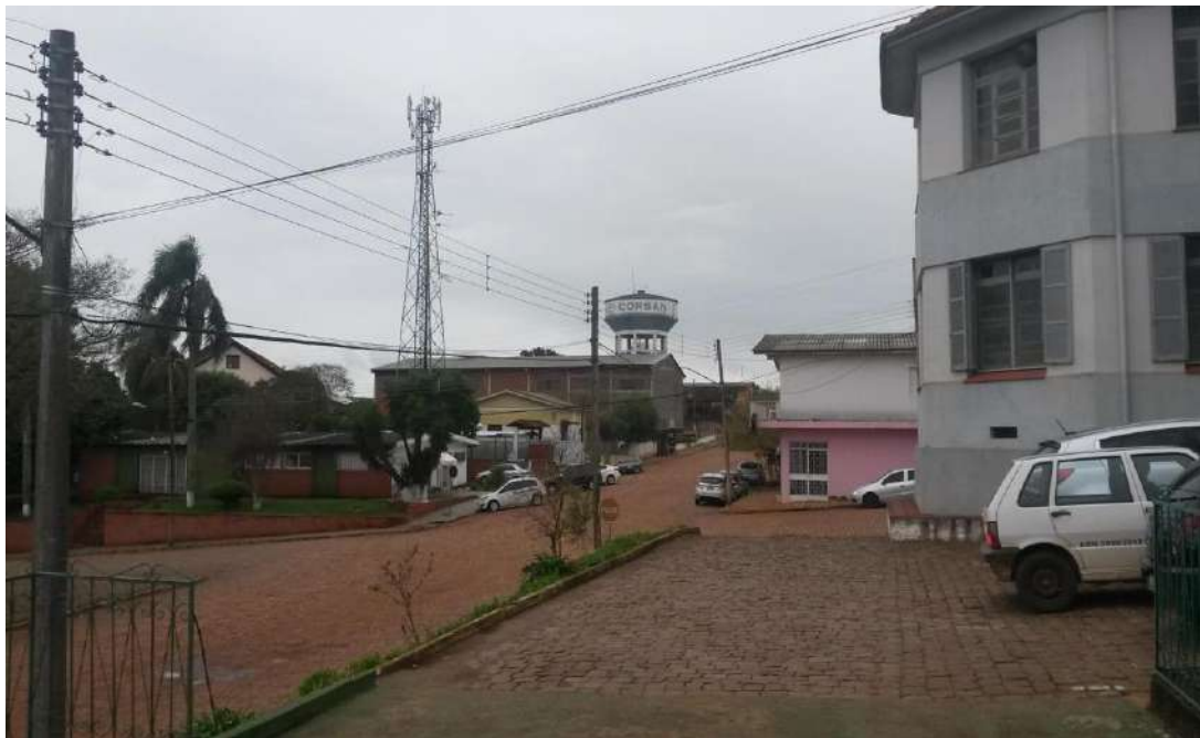
Figura 9: Reservatório elevado com capacidade de 250 m 3 (R-3).
