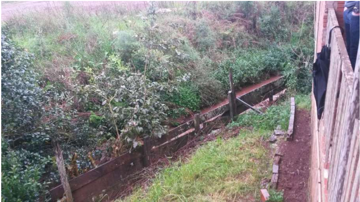
Figura 21: Residência localizada à margem do arroio.
